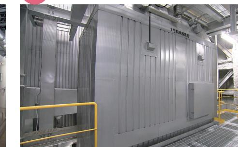
脱硝反応塔では、排ガスに気化させたアンモニア水を吹きかけて触媒を通して、窒素酸化物を環境に影響のない窒素と水に分解することで除去しています。
