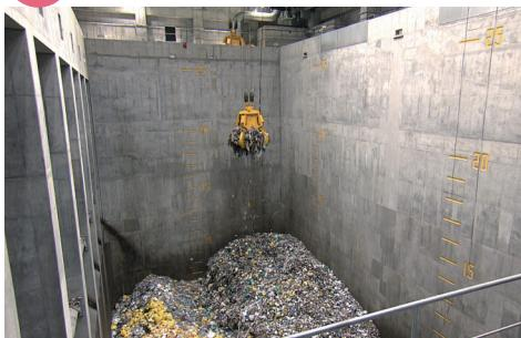
ごみピットには約1週間分のごみをためることができます。ためられたごみは、自動運転のごみクレーンにより焼却炉に投入されます。クレーンは最大で5tのごみを掴むことができます。
