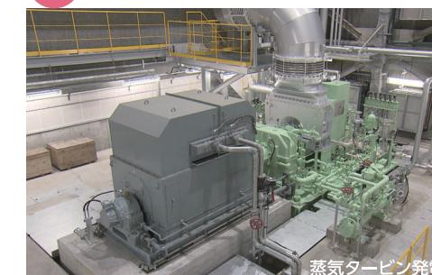
ごみを燃やして発生した熱をボイラに送り、水を加熱して高圧蒸気を発生させます。蒸気タービンの羽根を高圧蒸気で回し、発電機を動かして発電します。定格発電量は5,190kWです。
