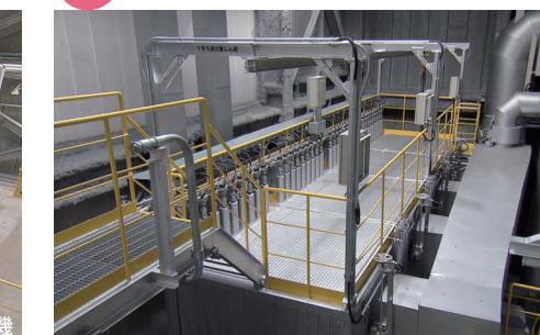
ろ過式集じん機では、排ガスに消石灰と活性炭を吹き込み、化学反応させて、ダイオキシン類、塩化水素、硫黄酸化物、水銀などの有害物質をろ過と呼ばれるフィルタで集めます。
