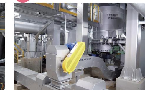
ろ過式集じん機で集めた飛灰を循環させ、未反応の消石灰を再利用します。これまで捨てていた未反応の消石灰を有効活用し、消石灰の使用量を削減するとともに飛灰の発生量を抑制します。
