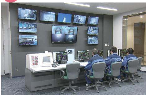
工場内の各設備の運転操作と監視を24時間自動で行います。各設備から制御用コンピュータに常時送られる情報や監視カメラの映像で、工場内各所の運転状況を把握します。
