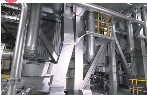
1日114tのごみを焼却できる焼却炉が2炉あります。炉内では850度以上の高温で燃やすことで、ごみを完全燃焼させるとともに、ダイオキシン類等の有害物質の発生を抑えます。
