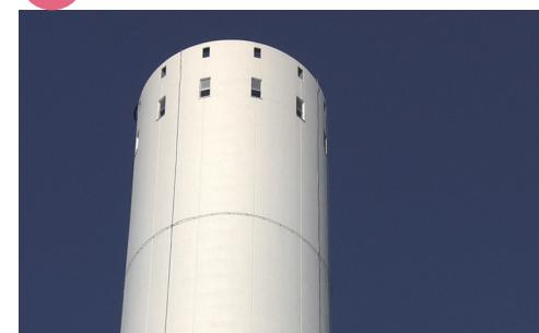
ろ過式集じん器や脱硝反応塔で処理された排ガスは、高さ85mの煙突から排出されます。排ガスに含まれる有害物質濃度は、全国トップレベルの厳しい基準値をクリアしています。
