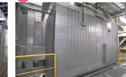
脱硝反応塔では、排ガスに化水させたアンモニア水を吹きかけて触媒を通して、窒素酸化物を環境に影響のない窒素と水に分解することで除去しています。
