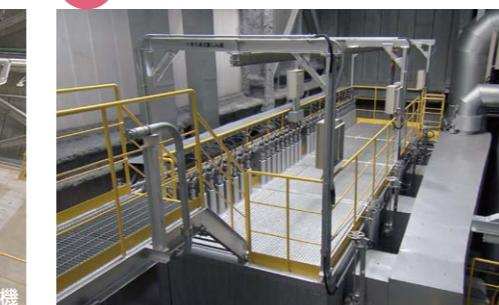
ろ過式集じん器では、排ガスに消石灰と活性炭を吹き込み、化学反応させて、ダイオキシン類、塩化水素、硫黄酸化物、水銀などの有害物質をろ過と呼ばれるフィルタで集めます。
