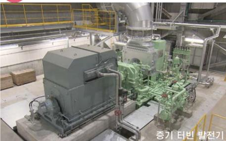
쓰레기를 태워서 발생하는 열을 보일러로 보내, 물을 가열하여 고압 증기를 발생하게 합니다. 증기 터빈의 날개를 고압 증기로 돌려서 발전기를 움직여 발전합니다. 정격 발전량은 5,190kW 입니다.
